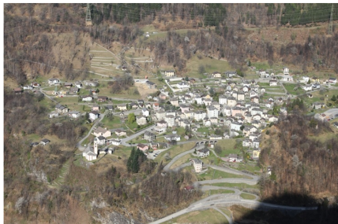
Überblick auf Soazza mit den sanierten Trockenmauern oberhalb des Dorfes.
