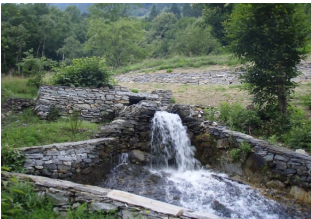
Ehemaliger Mühlbach bei den sanierten Trockenmauern in Molineda.
