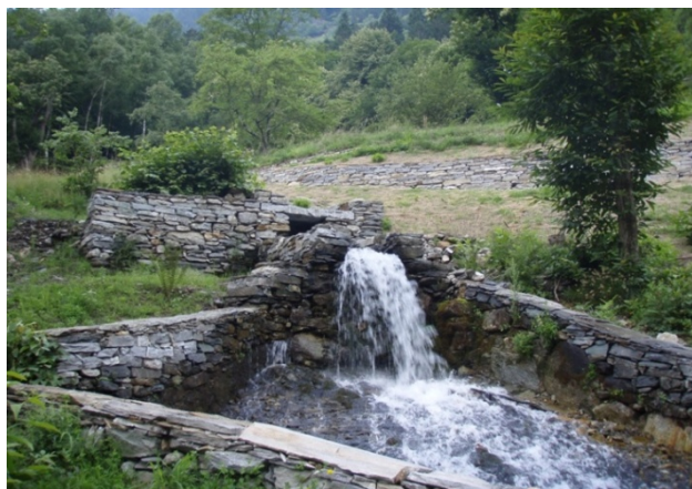
Roggia di Molineda presso i muri a secco di sostegno recuperati.
